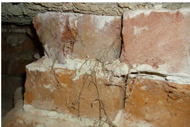
13 Mauerwerk im Bereich der Deckenbalkenebene durchwachsen mit dem Myzel des Echten Hausschwamms
