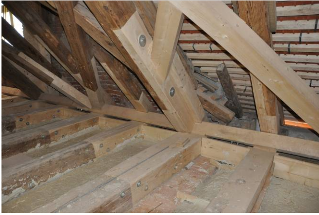
7 Querschnittsgleiche Fußpunktinstandsetzung der Bundbalken, Sparren, Stuhlstreben und Windverbandstreben.
