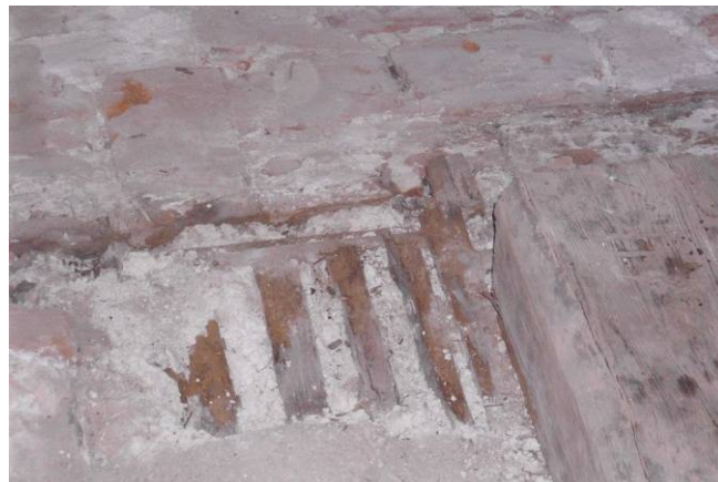
14 durch Echten Hausschwamm geschädigte Lattung der Stuckdecke
