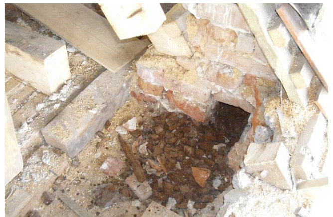
12 durch Echten Hausschwamm zerstörte Mauerschwelle aus Eiche
