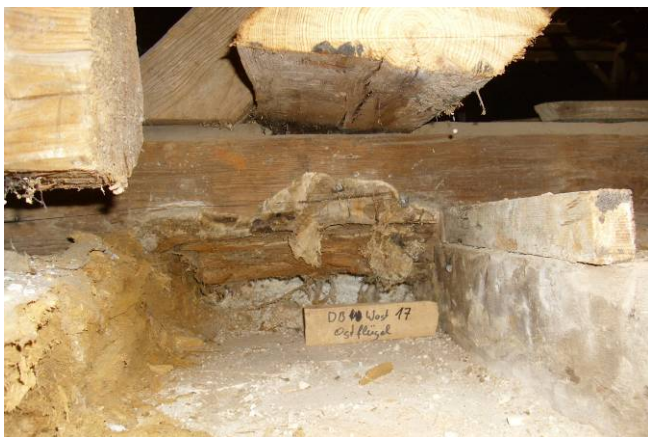
11 Im Rahmen der Baumaßnahme freigelegter Dachfußpunkt mit Myzel des Echten Hausschwamms
