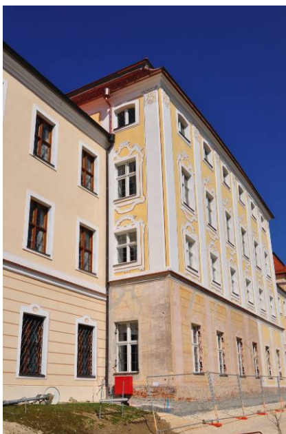
3 Ansicht Mittelrisalit mit ausbauchender Südfassade
