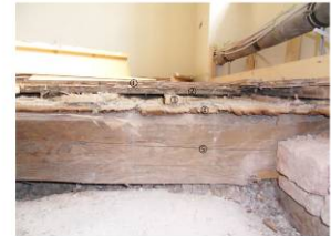
Foto 3: Detailaufnahme Bodenaufbau Sondieröffnung S 123
